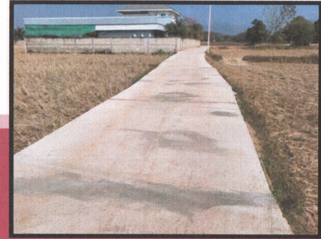
โครงการก่อสร้างถนน คสล.
